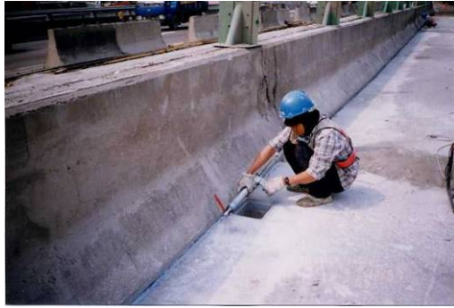
(g) 橋面版與護欄交接處灌注填縫膠
