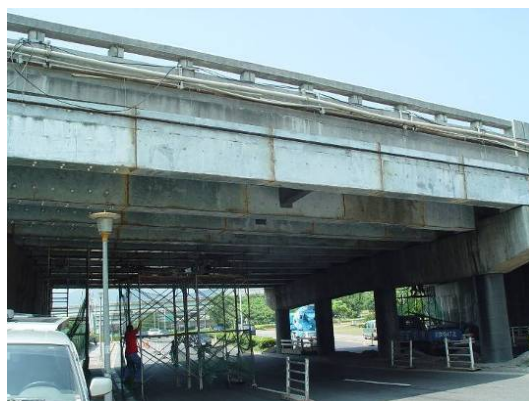
圖 4.16 鋼板黏貼補強完工照片
