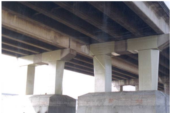
(f) 鋼板補強完成
