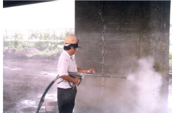
(b) 舊有混凝土表面打毛處理
