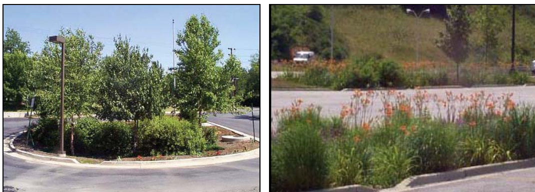
圖 3.48 停車場內(左)與分隔島(右)設置生態滯留槽
