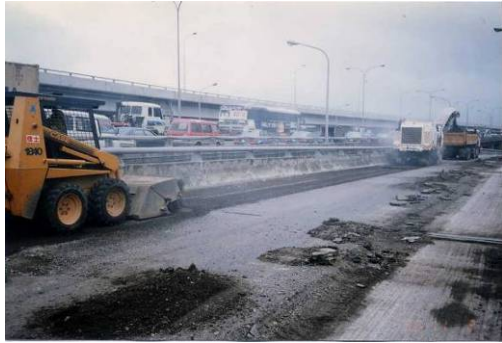
(a) 瀝青混凝土路面刨除
