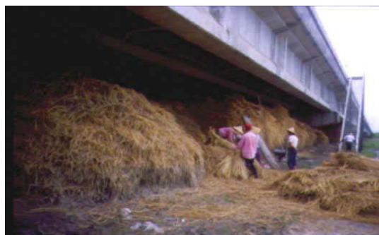
圖 4.6 橋下堆放易燃物
