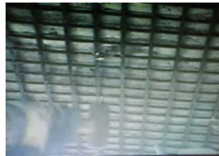
(d) FRP 格網裝設
