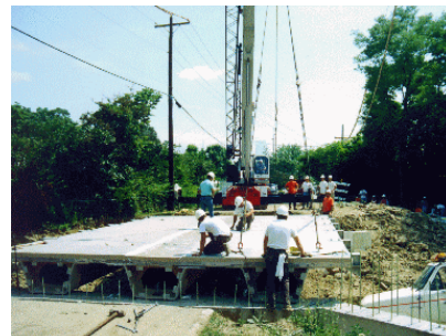
(f) 橋面版組裝完成
