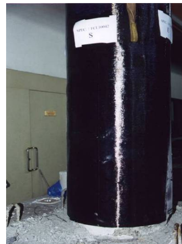
(i) 補強完成
