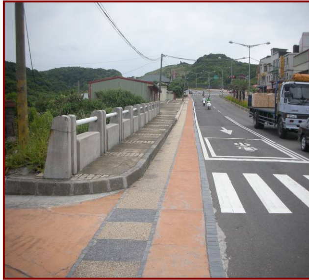
圖 3.73 淡金公路自行車道
