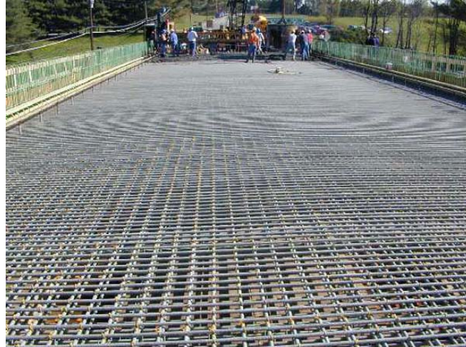
圖 4.46 FRP 鋼筋應用於橋面版取代傳統鋼筋
