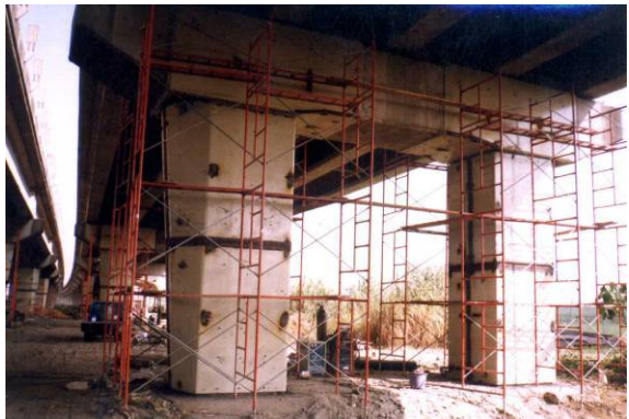
(d) 現場焊接，鋼板組立完成
