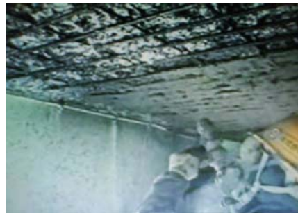
(c) 第一層噴凝土
