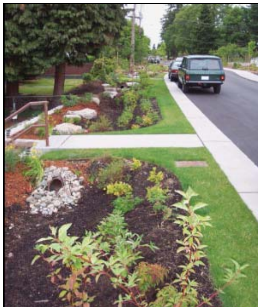
圖 3.50 西雅圖郊區旁草溝排水系統
