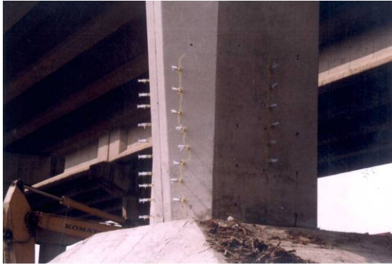
(a) 混凝土裂縫灌注修復
