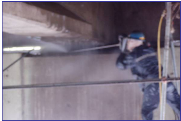
(b) 水刀式千斤頂置換橡膠支承墊
