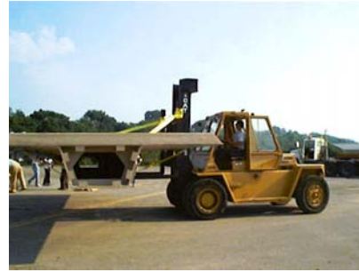
(b) 起重機運送作業
