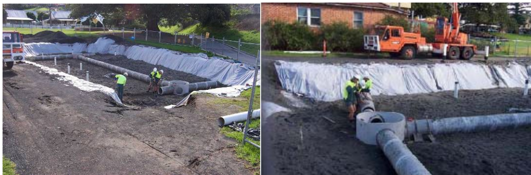
圖 3.12 Hindmarsh 公園滲透排水管施作案例
