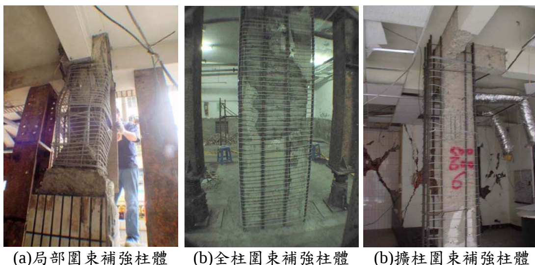
圖 4.30 鋼纜線圍束補強柱體作業
