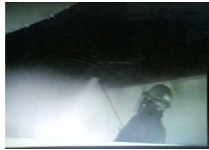
(b) 劣化部份清除
