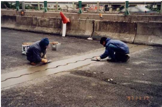
(i) 橋面伸縮縫換新
