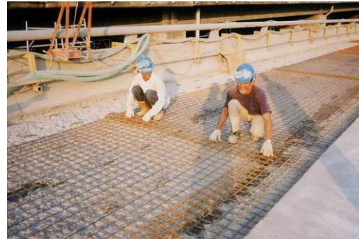
(d) 鋪設熔接竹節鋼筋網
