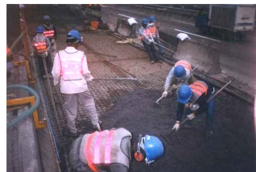
(f) 增厚橋面版鋪設鋼纖混凝土
