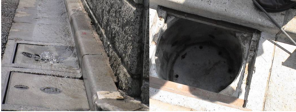
圖 3.21 東京滲透性排水系統水入滲情形
