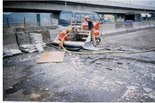
(b) 橋面版混凝土水刀刨除
