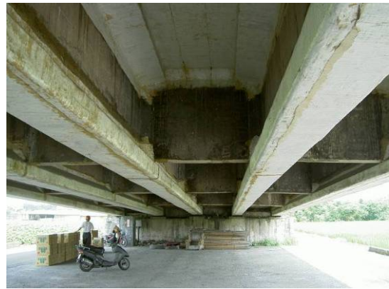
圖 4.18 纖維複合材料(FRP)貼布黏貼補強完工照片
