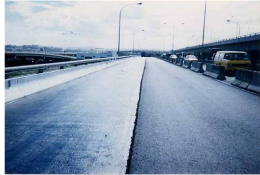
(h) 橋面鋪設瀝青混凝土路面
