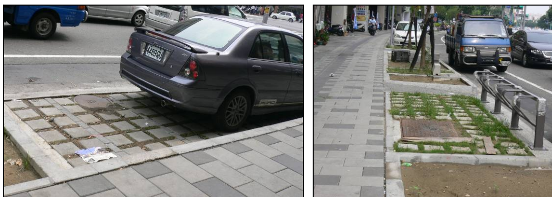
圖 3.23 明誠二路旁汽車與腳踏車停車格鋪設透水性鋪面
