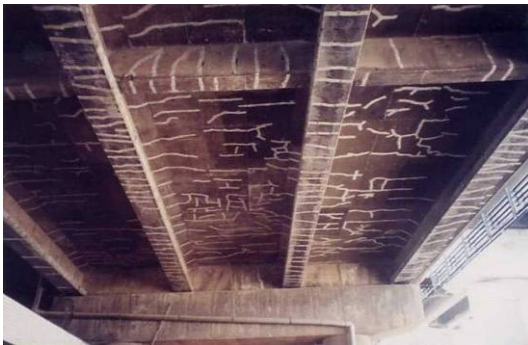
(k) 裂縫修補完成
