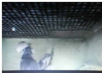
(e) 第二層噴凝土
