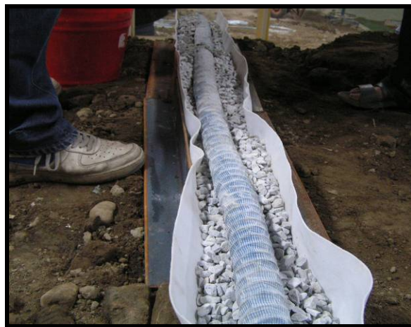
圖 3.56 滲透排水管鋪設
