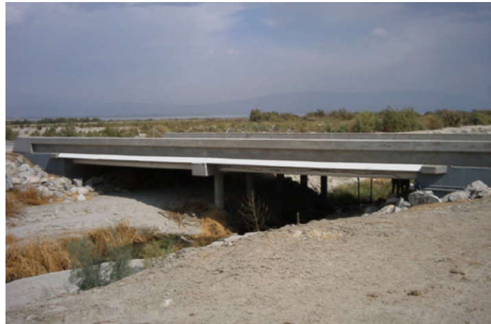
圖 4.37 Kings Stormwater Bridge
