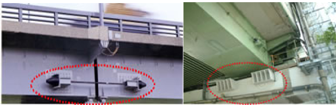
圖 2.2 橋梁上部結構補強方式
