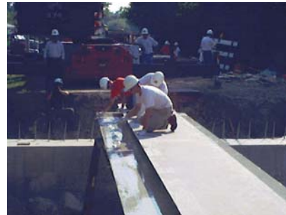
(d) 人工組裝作業
