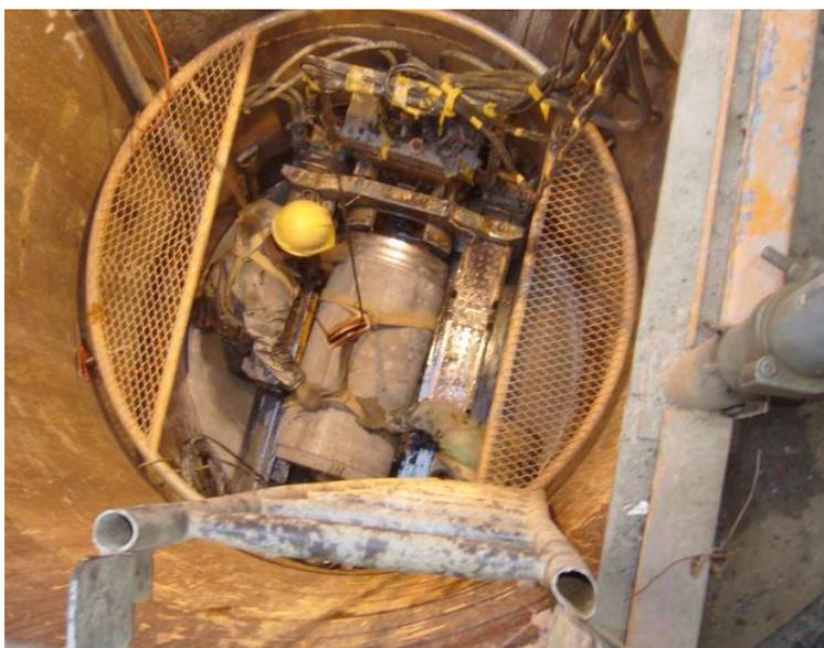
圖 5-16 土壓式工法推進管安裝工作
