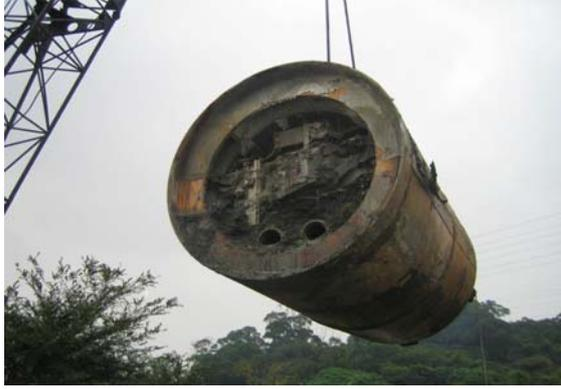
圖 8-3 反向拉機頭吊起作業
