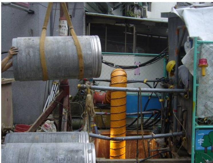
圖 5-15 推進管材吊放工作
