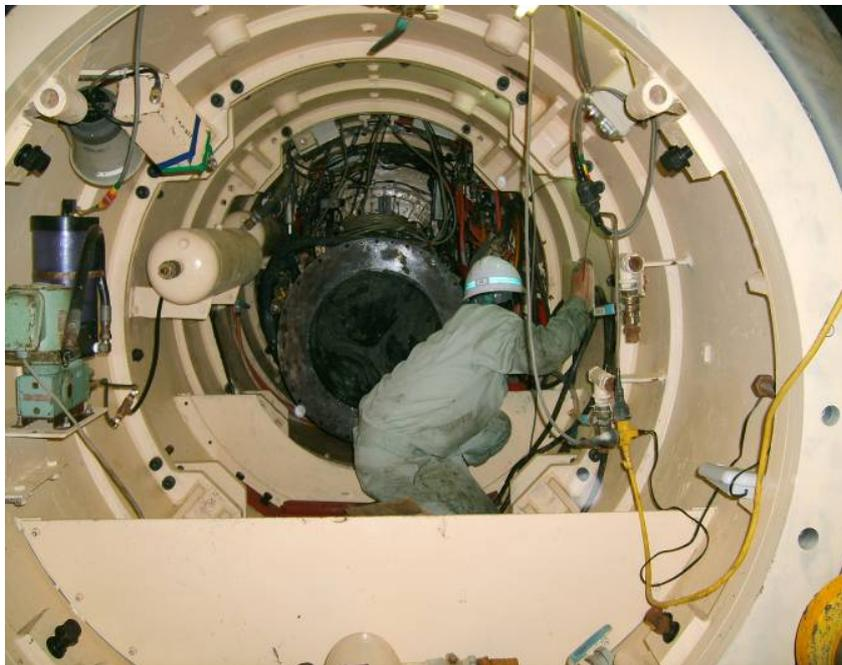
圖 5-6 掘進機立坑內設置 ( II )
