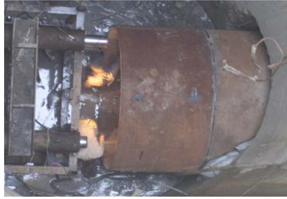
圖 8-4 機頭受困進行反向推鋼管
