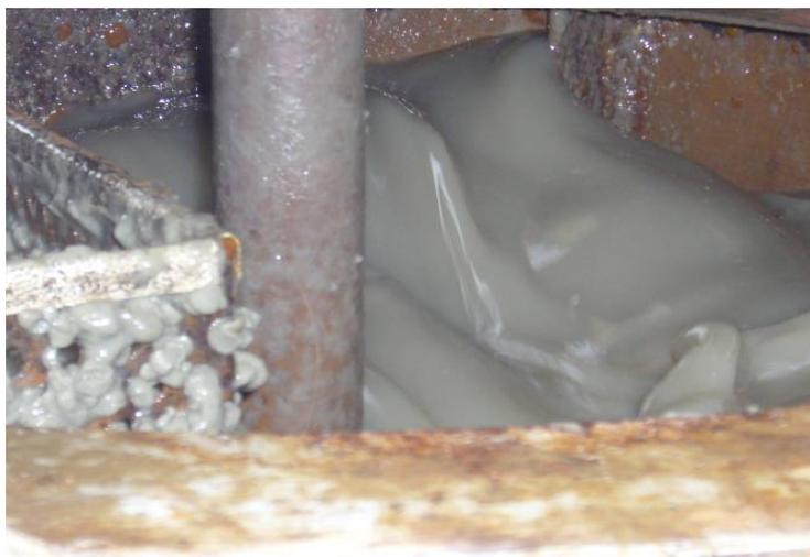
圖 5-18 土壓式工法添加材攪拌情形
