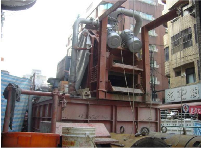
圖 5-25 泥水式工法注入材設備
