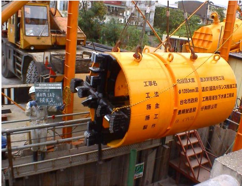
圖 5-5 掘進機立坑內設置 ( I )
