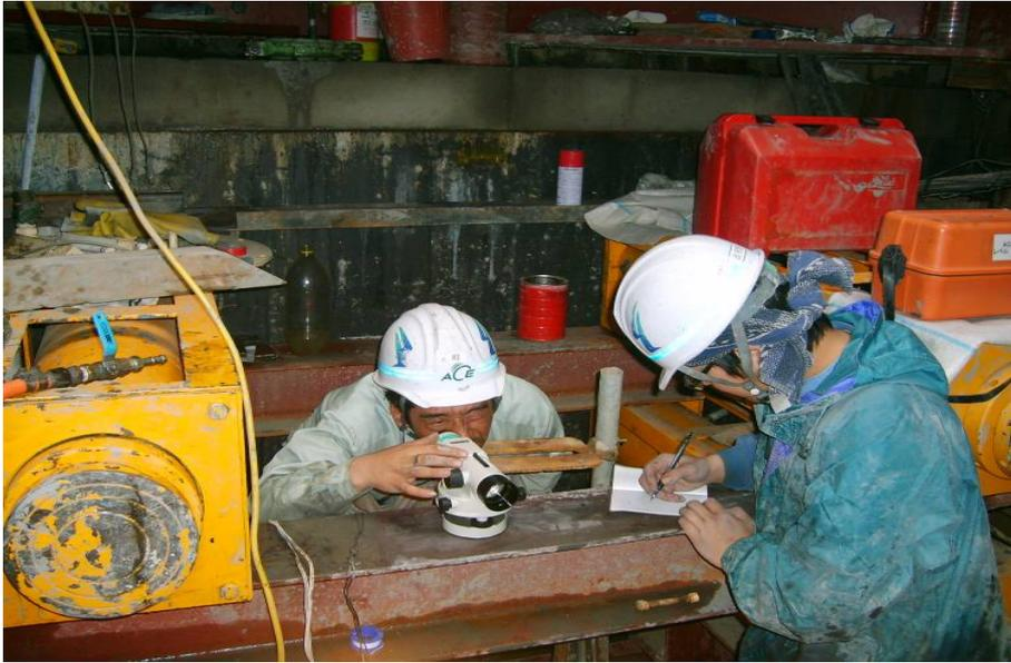
圖 5-2 準備工程基準點測定
