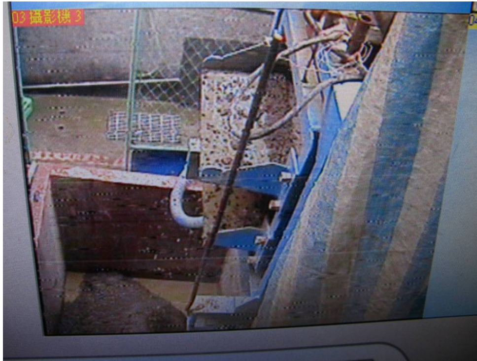
圖 2-35 推進工法自動化收集：出碴的監控
