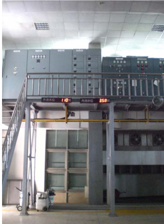
圖 4-52 南港抽水站架高內部控制設備
