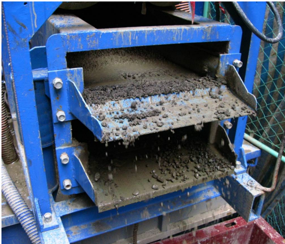
圖 2-36 推進工法自動化收集：出碴狀況
