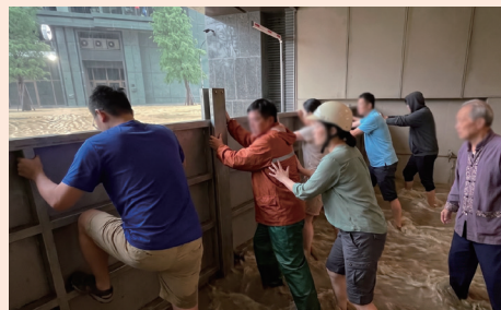
防水閘門應預先佈設
