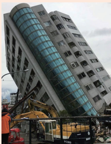
大樓傾斜倒塌
