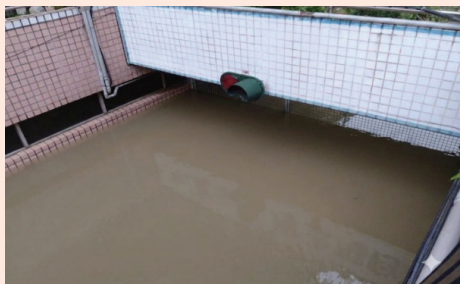
社區地下室停車場淹水
