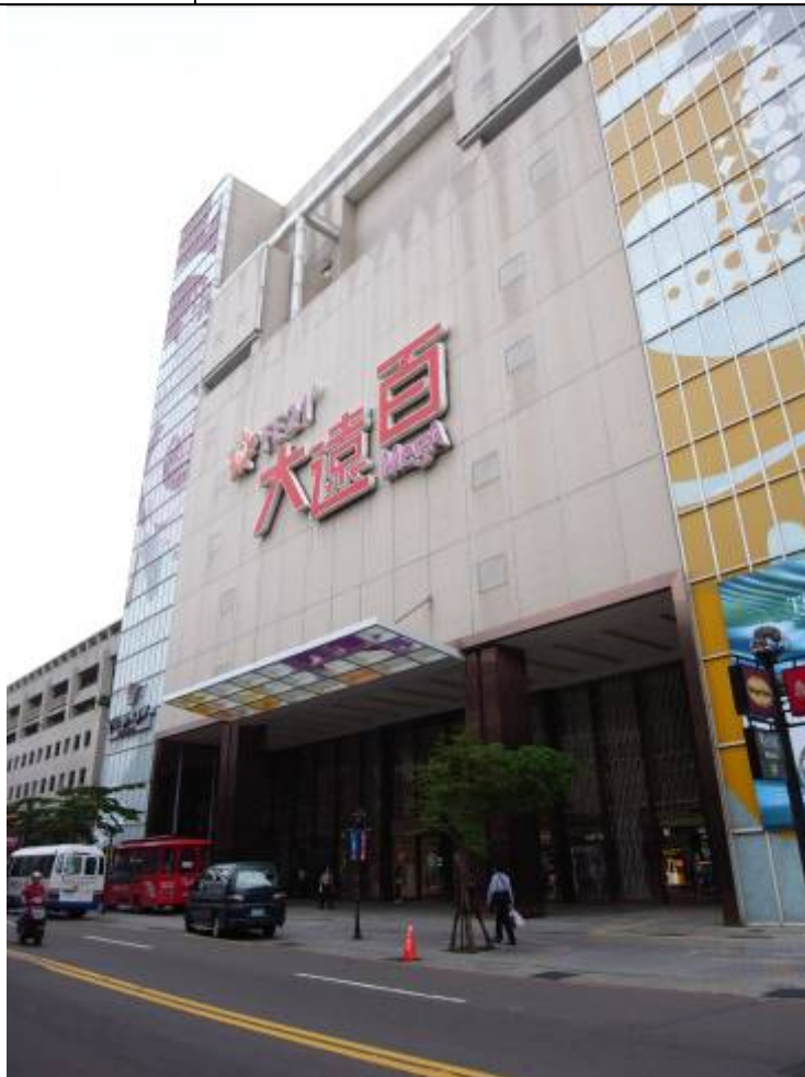
公共建築物設置供行動不便者使用設施現場會勘
