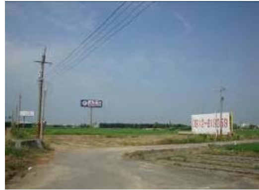
現勘情形：高速公路違規樹立廣告 (拆除後)
