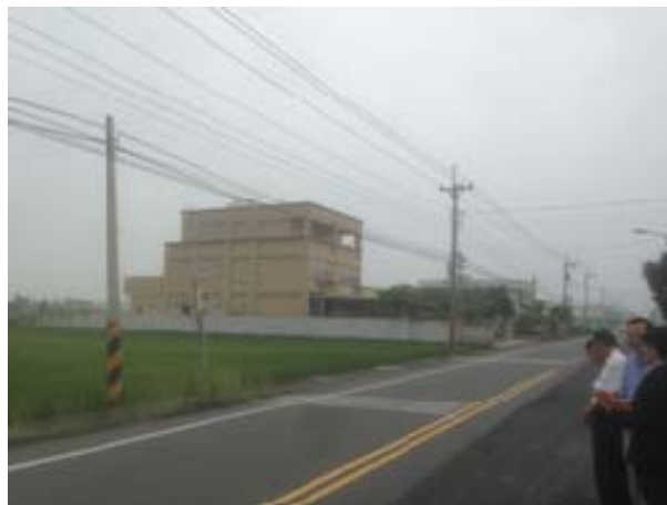
斗六市報長路 157 號對面 拆除後
