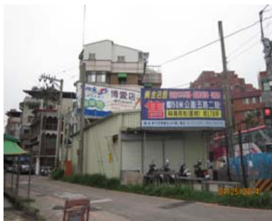
現勘情形（違規廣告拆除後現況）
