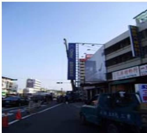
彰化市中央路 291 號歐德系統傢俱 拆除前
