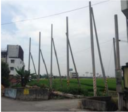
現勘情形（違規廣告拆除後現況）
