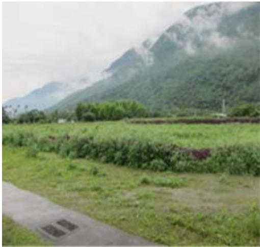
(台 9 線秀林鄉段) 現勘情形 1
