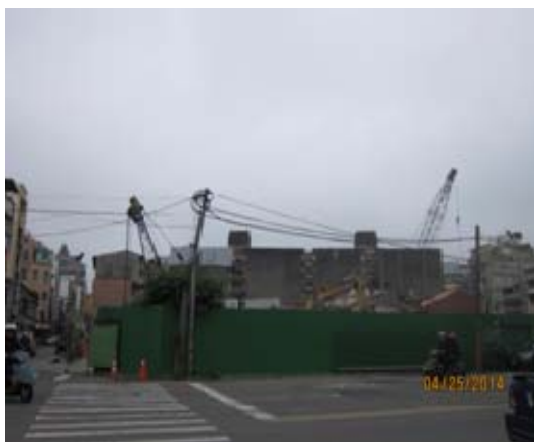
現勘情形（違規廣告拆除後現況）
