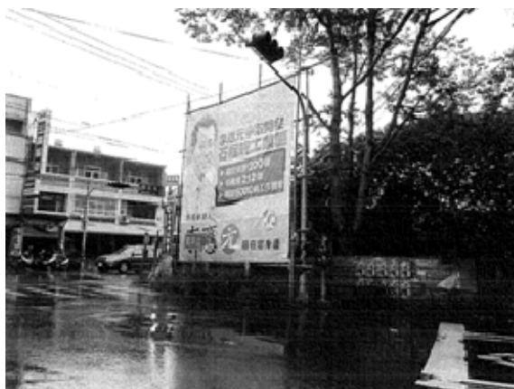
斗六市鎮北路與萬年路交叉路口 拆除前
