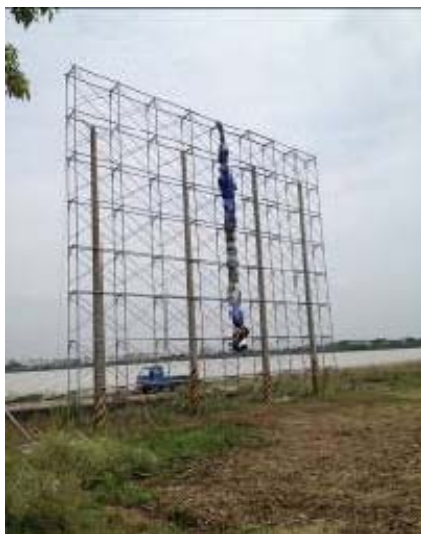
現勘情形：高鐵大道嘉義縣段
