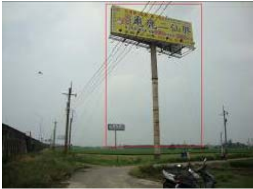
現勘情形：高速公路違規樹立廣告 (拆除前)
