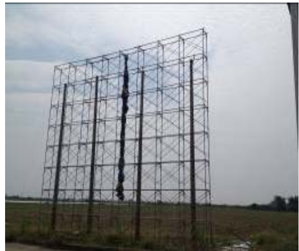
現勘情形：高鐵大道嘉義縣段
