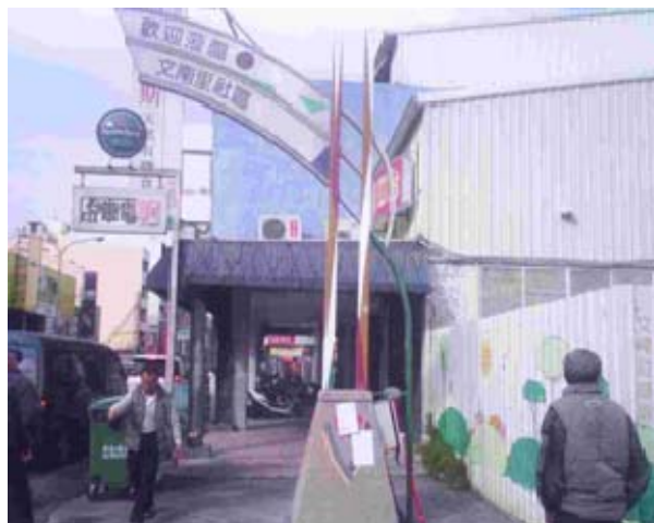
（南區健康路二段）拆除前
