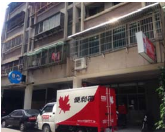
現勘情形（違規廣告拆除後現況）
