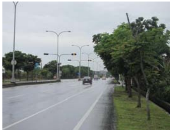
(台 9 線秀林鄉段) 現勘情形 4
