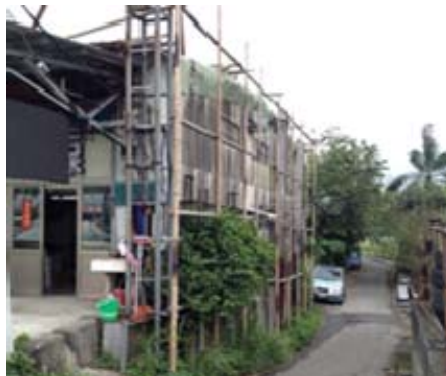
承德路 6 段違規廣告物拆除後
