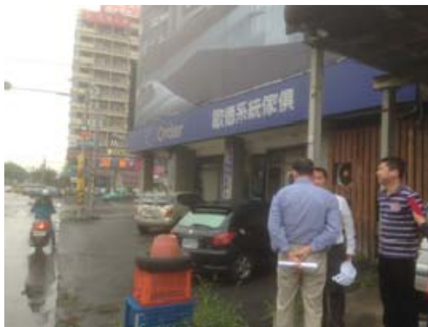
彰化市中央路 291 號歐德系統傢俱 拆除後
