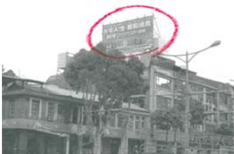
重慶北路違規廣告物拆除前
