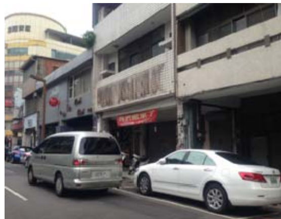
現勘情形（違規廣告拆除後現況）
