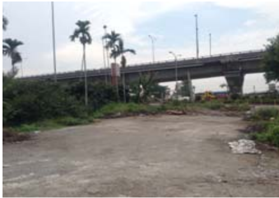
現勘情形（違規廣告拆除後現況）
