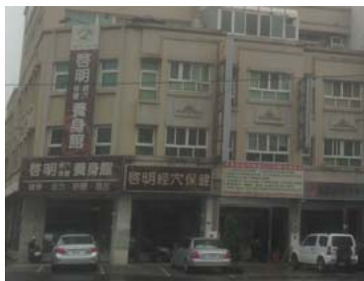
彰化市中華西路 340 號啟明經穴保健拆除後
