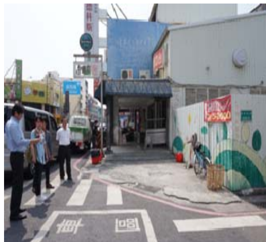
（南區健康路二段）拆除後
