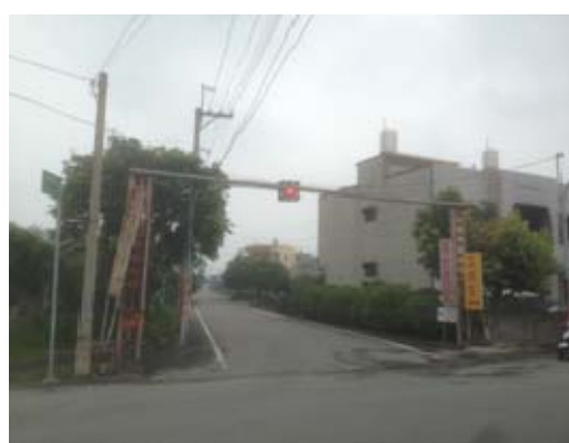
斗六市埤頭路與埤頭北路交叉口 拆除後
