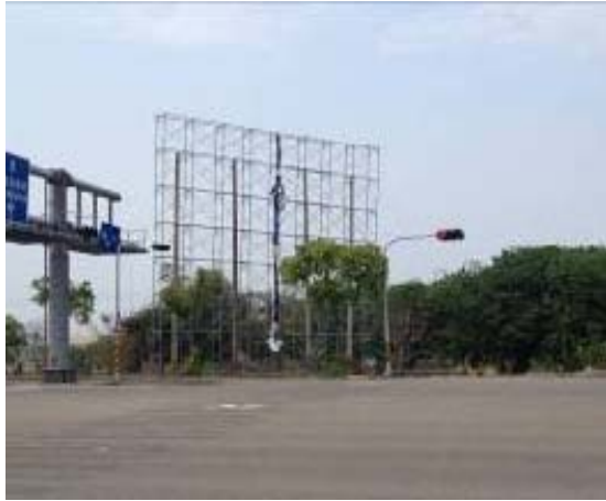
現勘情形：高鐵大道嘉義縣段
