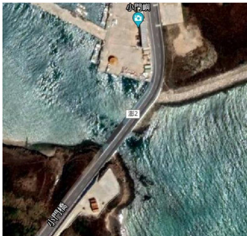
水流處為橋孔位置
