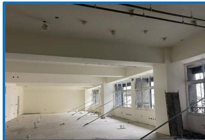
施工架壁連桿改至室內，避免外牆工程導致色差及不平整
