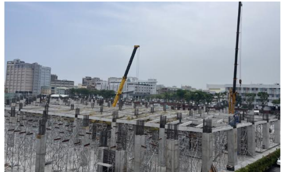
預鑄RC梁吊裝施工照片
