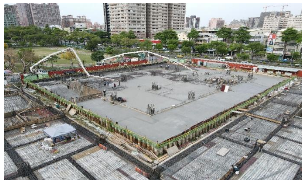
與鄰案同時並行完成地下室開挖
