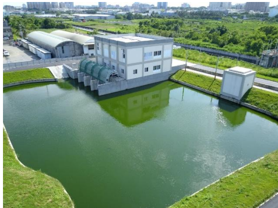
臺南市永康區大灣抽水站
