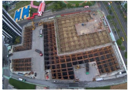
本工程與鄰案面臨兩邊同時開挖之困難
