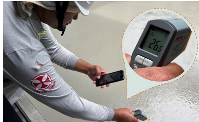
氣冷式混凝土，於低於28度下澆置，減少龜裂
