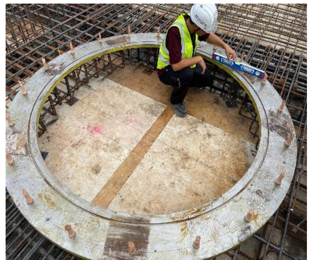
設備精準安裝技術
