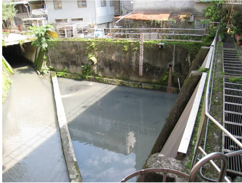
圖 4 中港抽水站內池（前池）
