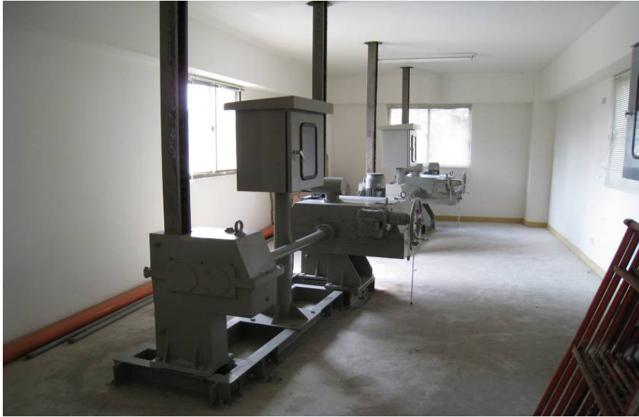
圖 8 重力閘門及 12CMS 抽水機外池維修閘門操作設施
