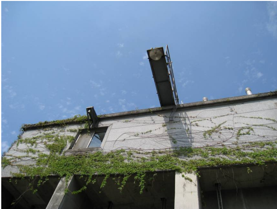
圖 12 重力閘門上方超音波水位計
