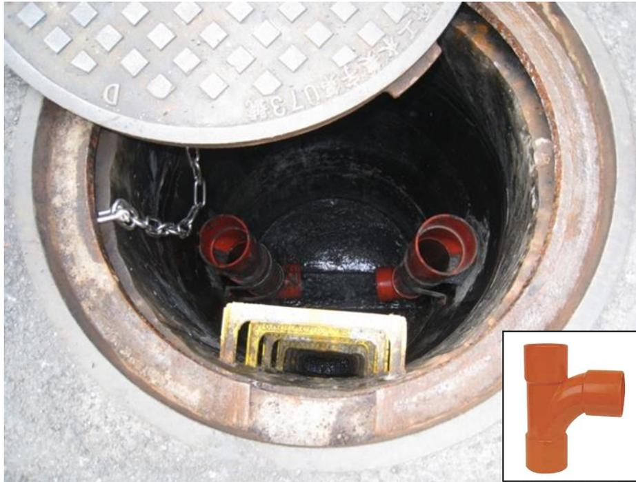
圖 6.13 人孔內跌落設施(順 T 型 PVC 管製)
