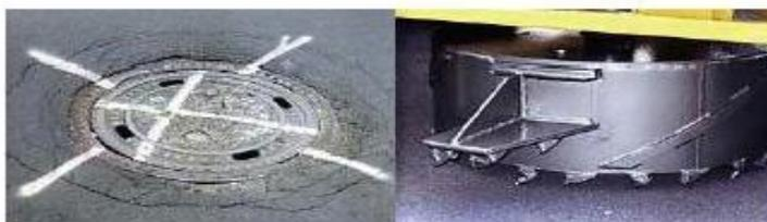
2. 將破損之人孔框蓋進行切割(費時 1-3 分鐘)
