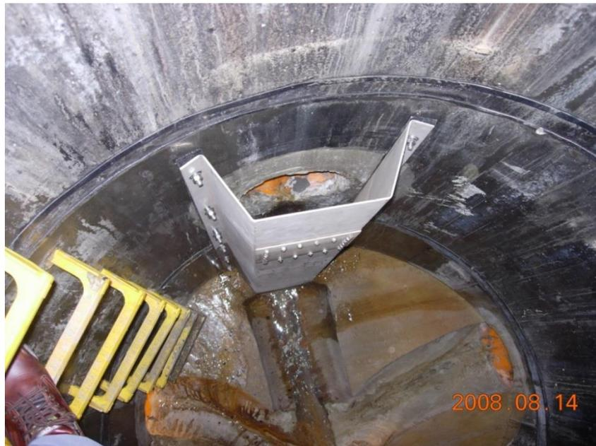
圖 6.12 人孔內跌落設施(門型不鏽鋼板製)
