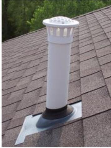
圖 6.26 一般住宅排水屋頂通氣管
