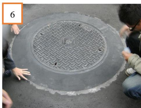
(人孔調整層採高流動性無收縮水泥，道路鋪面採樹脂瀝青混凝土)
