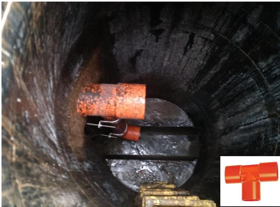
圖 6.14 人孔內跌落設施(正 T 型 PVC 管製)
