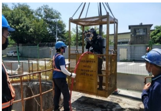
圖 10 凱旋主幹管水下銑孔人員準備作業
