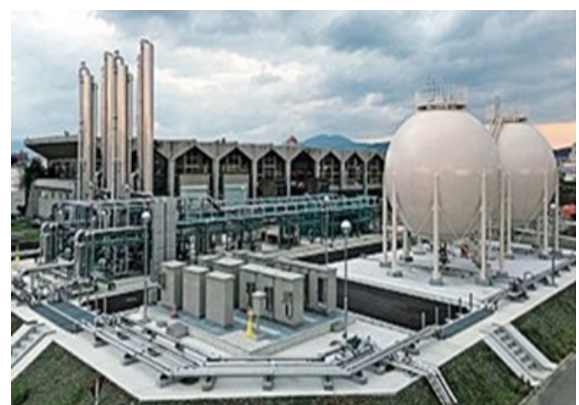
圖 7 京都市鳥羽水環境保全中心之兩座球形消化槽
