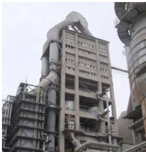
圖 9 亞洲水泥花蓮廠預熱機/旋窯系統
