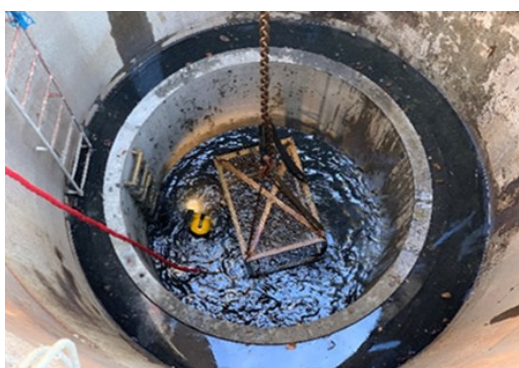
圖 11 凱旋主幹管鑽掘取水水下作業
