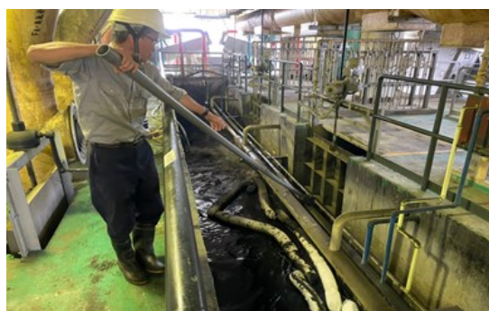
圖 18 細攔污柵共同渠道大量油污累積
