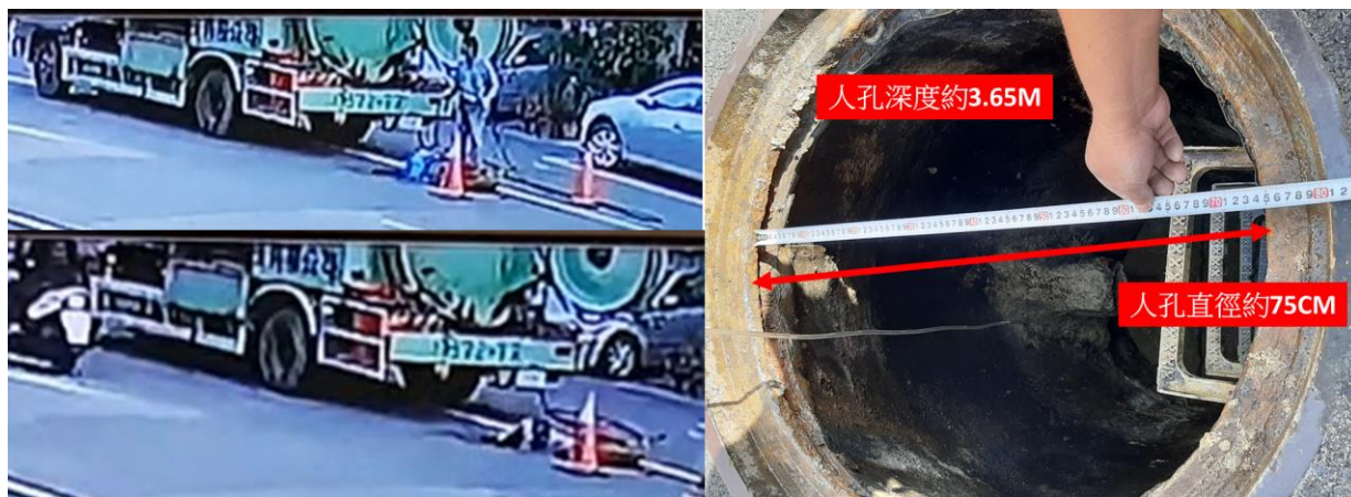
圖 2.4-2 現場作業畫面及污水人孔示意圖
