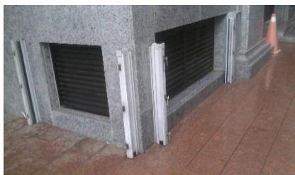
圖 5-2-10 車道口裝設金屬防洪（開啟式）閘門 圖 5-2-11 地面層建築主體周圍牆壁，車道防洪閘門高度以下的開口，均需設置防洪閘版
