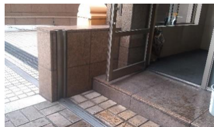
圖 5-2-10 車道口裝設金屬防洪（開啟式）閘門 圖 5-2-11 地面層建築主體周圍牆壁，車道防洪閘門高度以下的開口，均需設置防洪閘版
