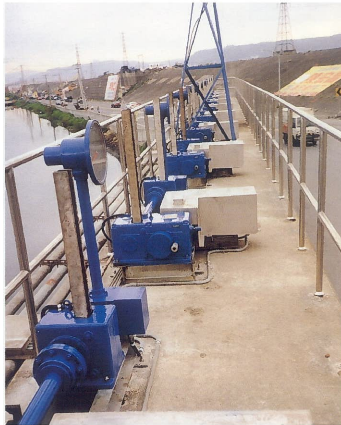
圖 3-15 雙桿(吊桿式)吊門機示意圖
