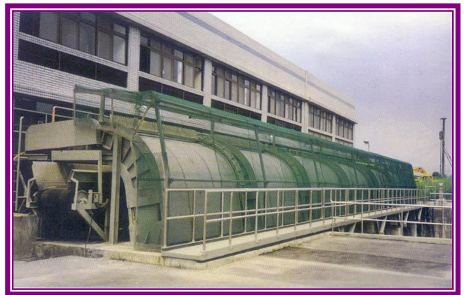
圖 4-2 刮耙迴轉式撈污機示意圖
