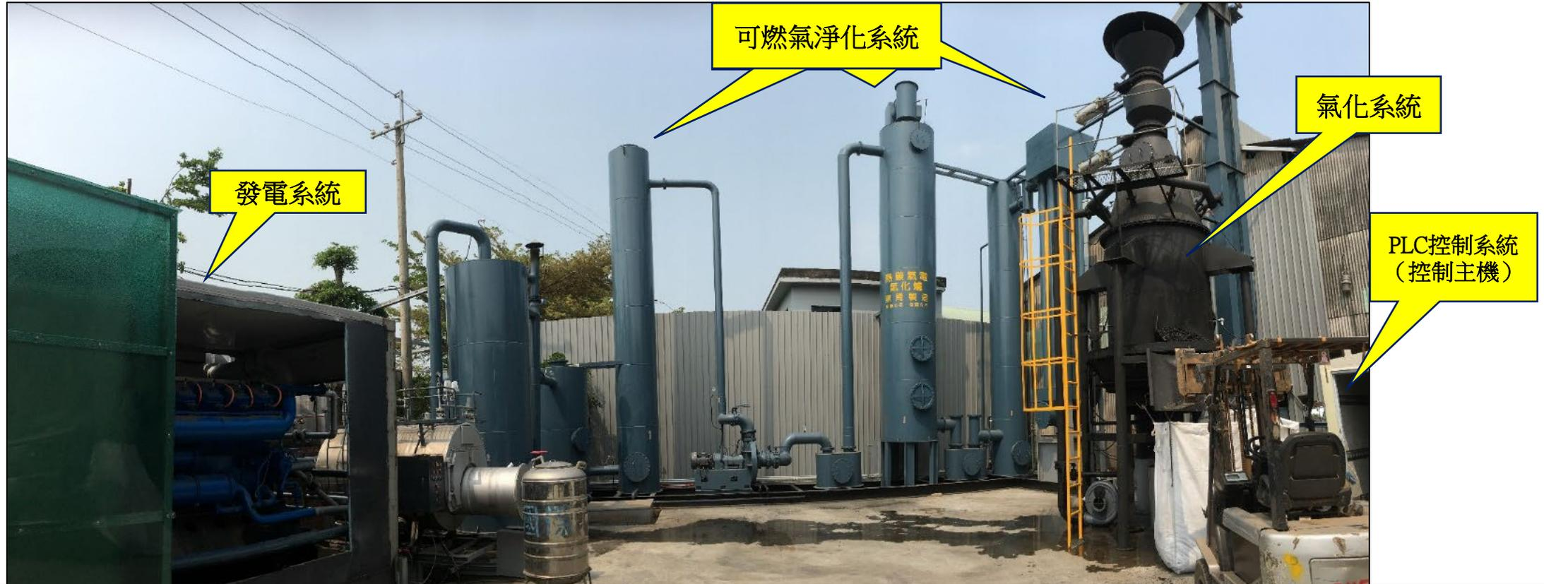
**500KW**生物質氣化發電站設備配置條件:日處理量:約15~18噸(原物料)
