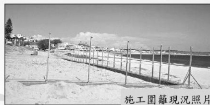
施工圍籬現況照片
