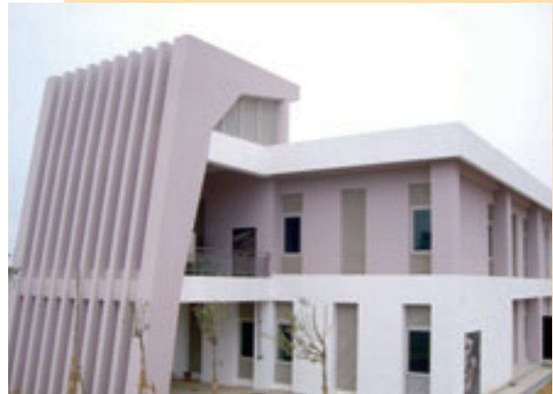
▲苗栗水資源中心污泥處理機房
