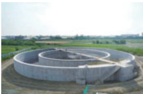
▲ 朴子污水處理廠二沉池施工
