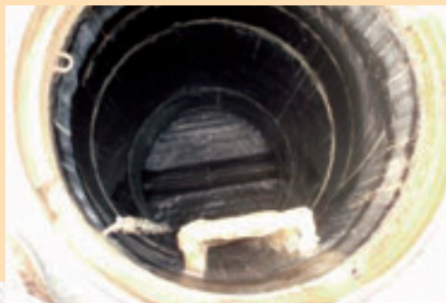
▲平山區明挖工程人孔導槽
