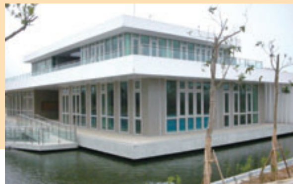
▲苗栗水資源回收中心管理大樓與景觀水池
