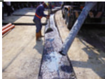
▲大樹四標前巷CLSM回填澆置
