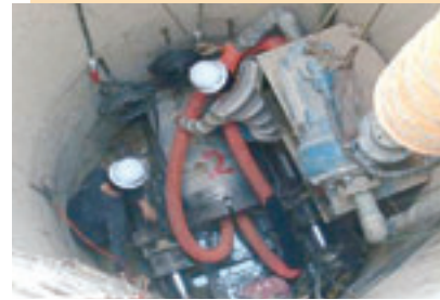
▲民雄管線二標推進施工
