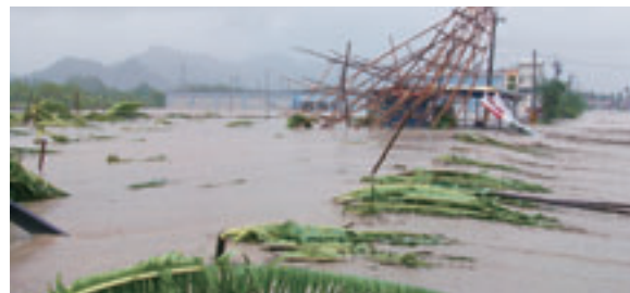
▲98年8月旗美污水處理廠受莫拉克颱風侵襲之淹水情形
