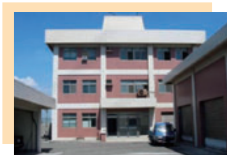
▲關連污水處理廠管理大樓
