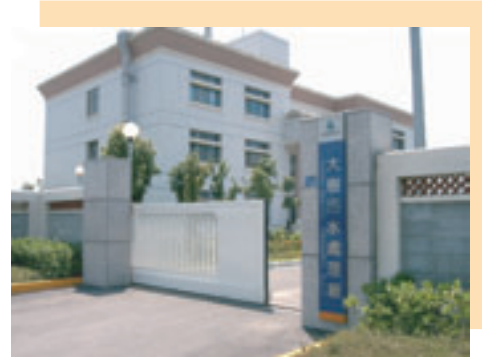
▲大樹污水處理廠大門
