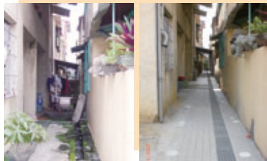
▲鳳山鳥松污水系統用戶接管施工前後
