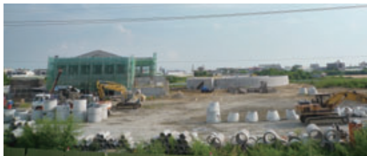
▲ 朴子污水處理廠施工
