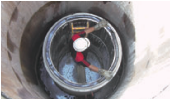
▲赤山集污區一標人孔施築
