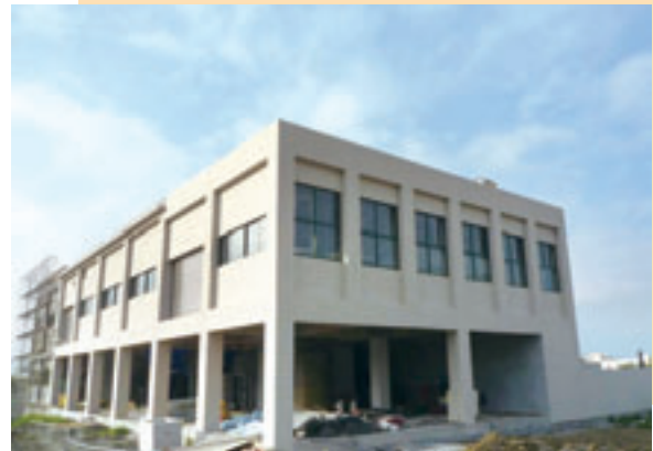
▲ 朴子污水處理廠多功能機房施工
