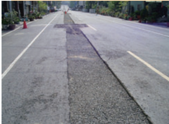
▲大埔污水下水道系統明挖管線路面回填
