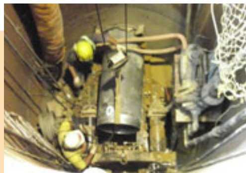
▲彰南路推進工程機頭入坑
