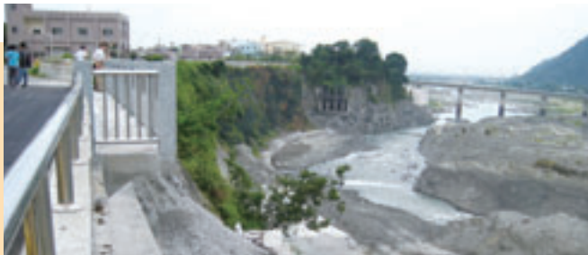
▲石岡壩污水處理廠護岸工程
