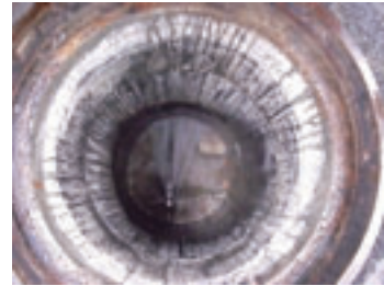
▲大樹四標管內清洗作業
