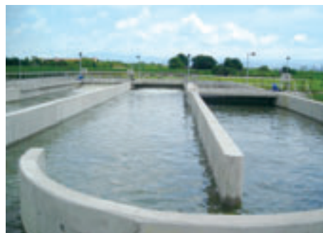
▲官田污水處理廠氧化渠
