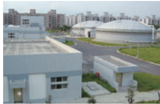
▲鳳山溪污水處理廠大門
