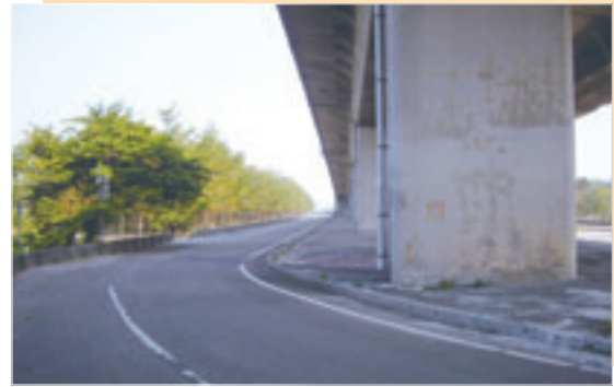
▲仁德污水處理廠預定地
