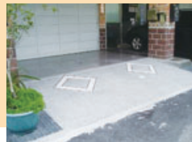
▲斗六污水系統前巷用戶接管完工
