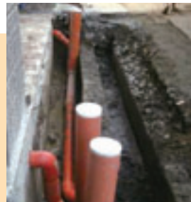
▲文新街50號用戶接管施工
