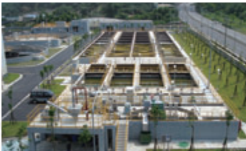
▲大樹污水處理廠鳥瞰圖
