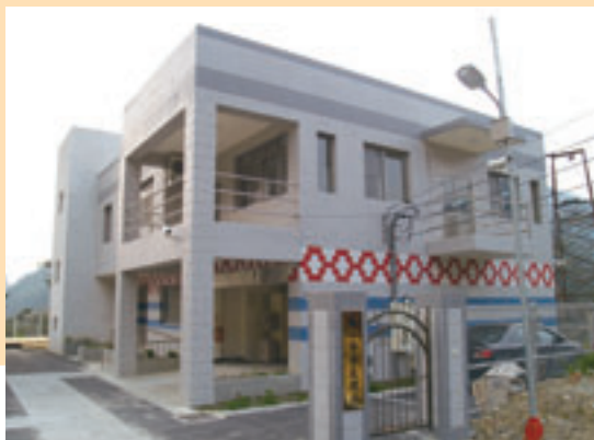
▲環山地區污水處理廠
