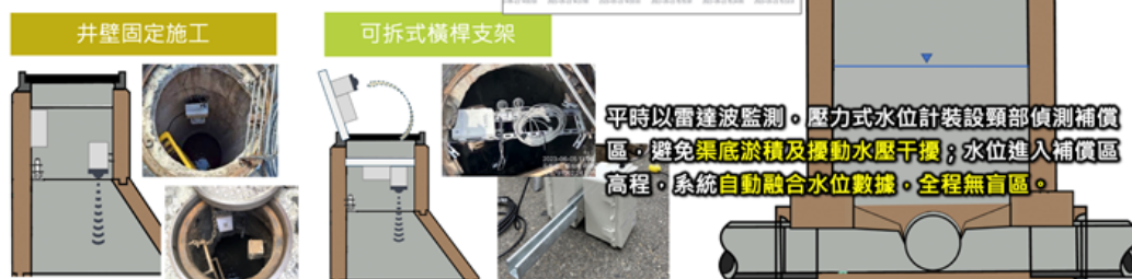
圖 3 IoT 複合式下水道水位計
