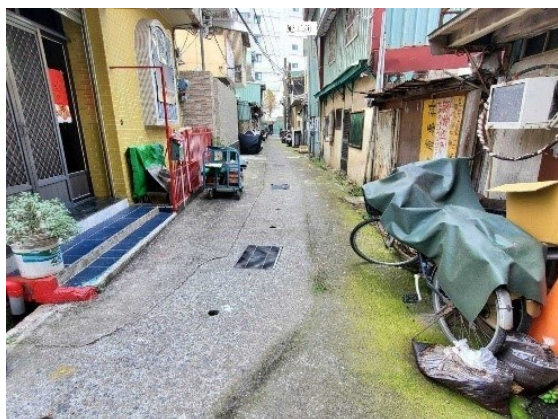
圖 5 第 2、3 標施工前後巷
