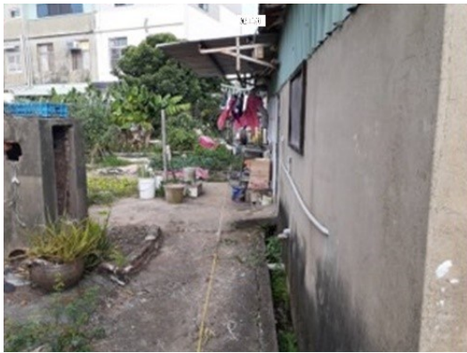
圖 8 第 4、5 標施工前後巷
