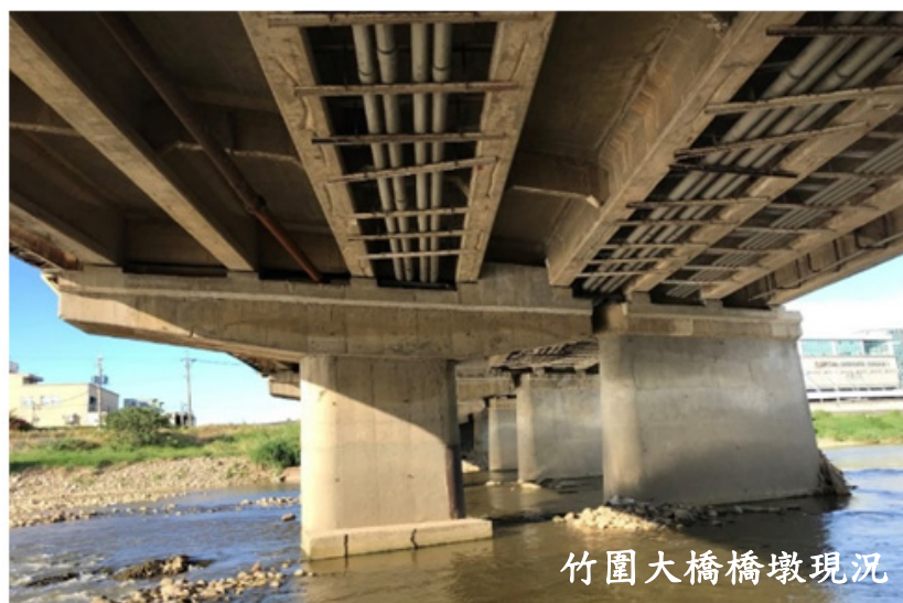
圖5-4 竹圍大橋橋梁現況照片
