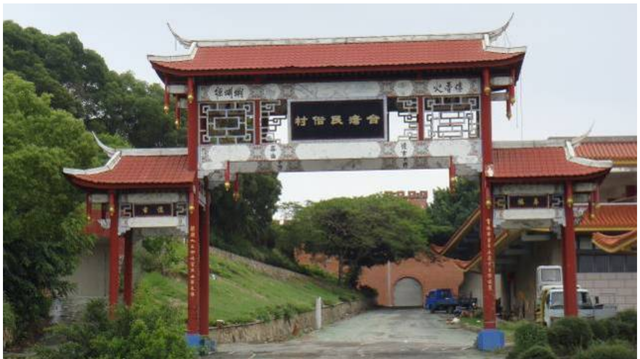
台灣民俗村(遊樂設施入口大門封閉)
