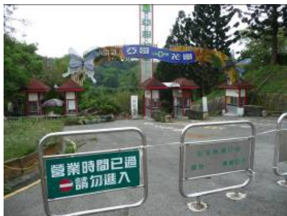
現場停止使用入口封閉
