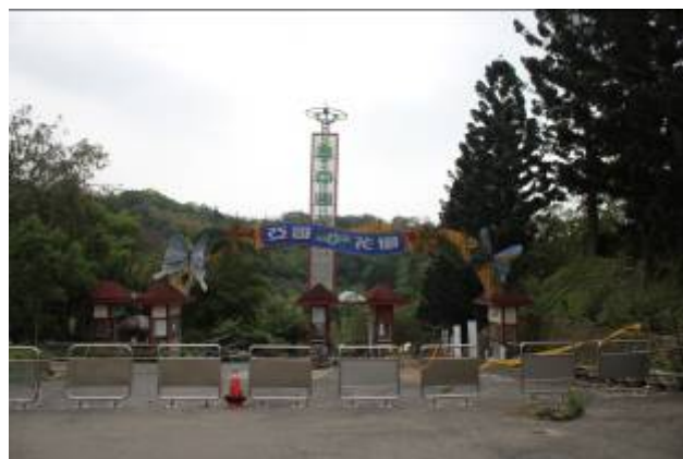
現場停止使用入口封閉
