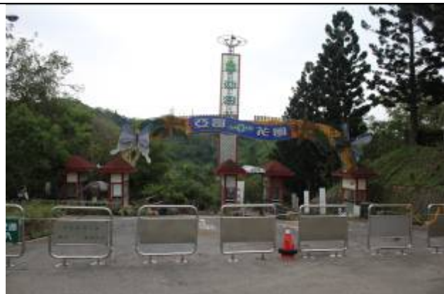
現場停止使用入口封閉
