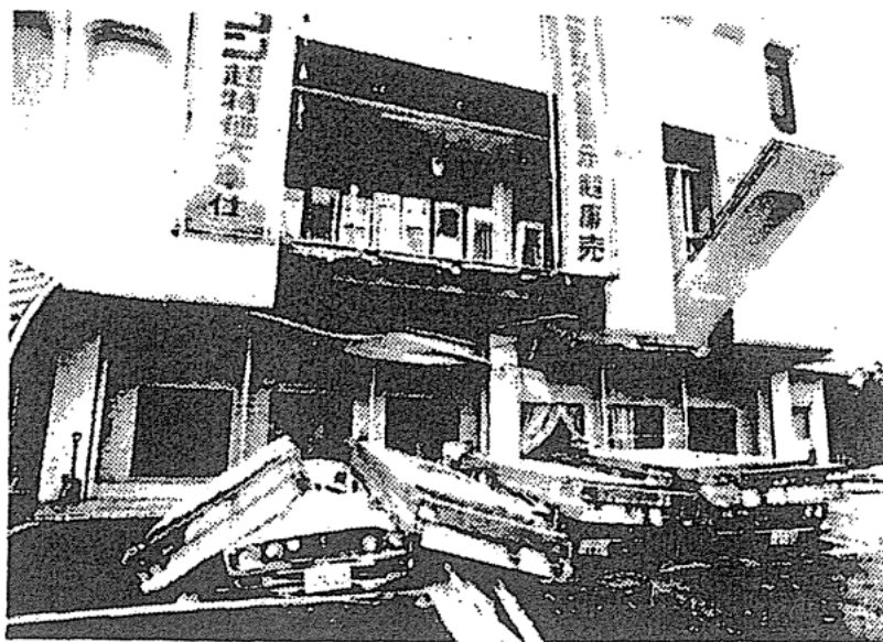
圖 R7.30 預鑄板因地震而脫落之例 (日本) [7.5]
