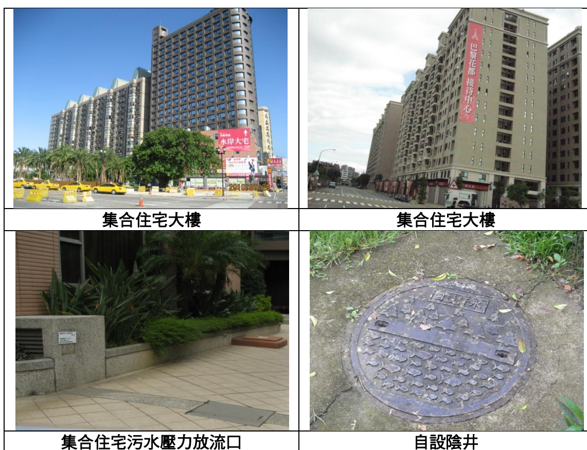
圖 3.5-4 集合住宅大樓建築範例
