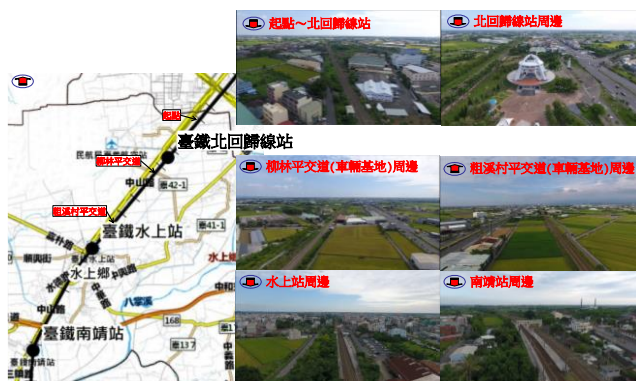
圖 2-2- 51 水上鄉鐵路高架範圍及沿線現況
