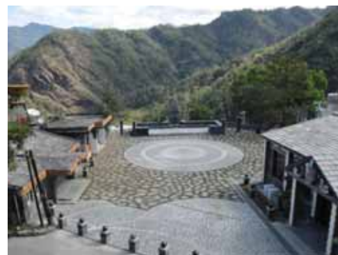
山海劇場建設
