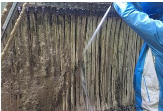
圖 17 人工清洗薄膜
