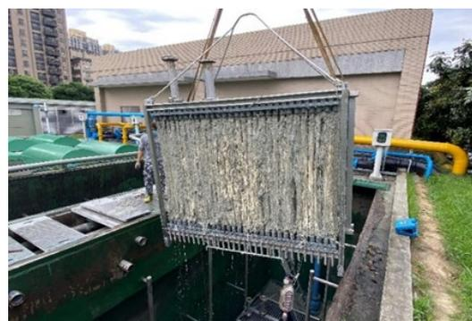
圖 18 薄膜設備吊離槽池
