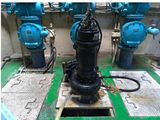
圖 16 進流抽水泵清理 (吊洗)
