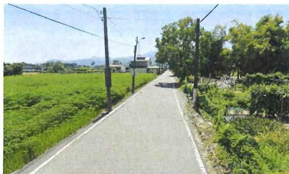
改善前(管線架空)
