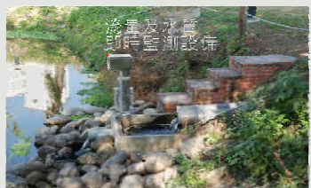
FWS 濕地出流口： 濕地淨化後的清澈水由此流至生態池
