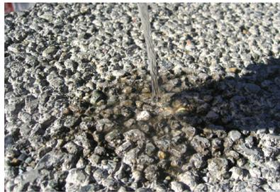
透水混凝土鋪面
