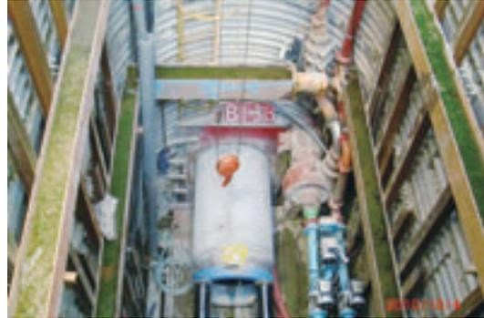
▲臺中市污水系統管線工程RCP推進管吊裝
