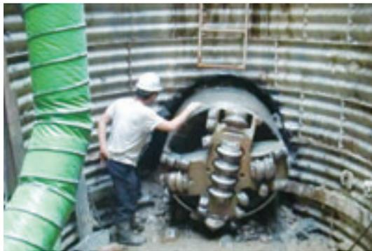
▲臺中市污水系統管線工程推進機頭出坑
