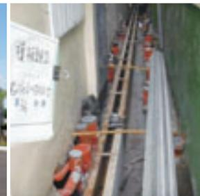
▲屏東市污水系統用戶接管後巷水溝模板組立施工
