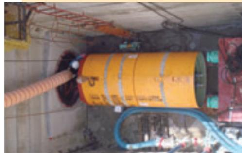
▲臺南市污水系統EFH第一標1,200mm管線推進工程施工
