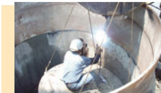
▲臺南市污水系統D幹管第一標2,090mm立坑鋼環焊接
