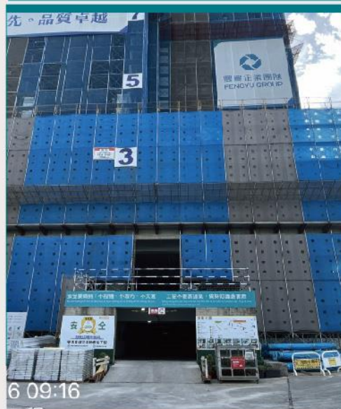
防塵網施工架外觀
