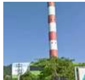
樹林垃圾焚化廠
