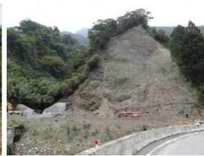
04：已進行坑溝整治及崩塌地治理工程
