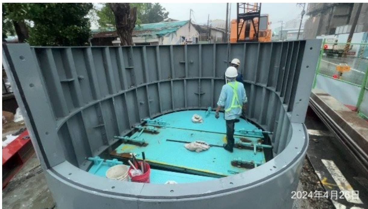
圖 7 異形工作井鋼環片組裝照片
