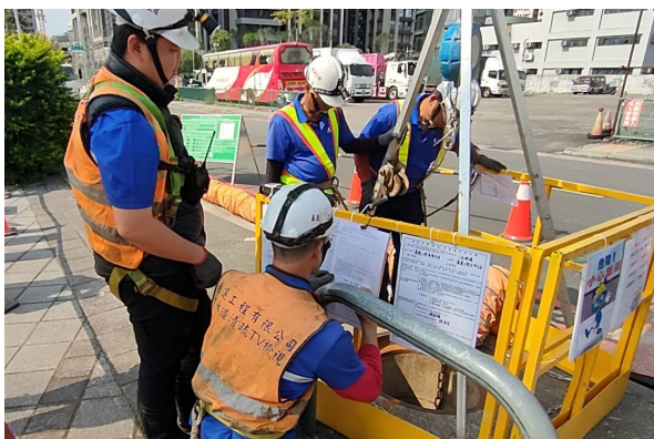
圖 7 現場人員安全監視示意圖—外部監視人員隨時監看（左）、人員進入後持續送風換氣（右）
