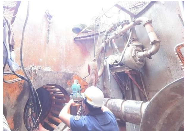
圖 12 曲線推進地下投影放樣
