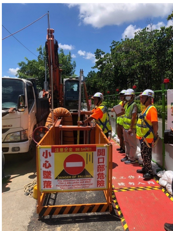
圖4 擋土支撐現場設置照片
