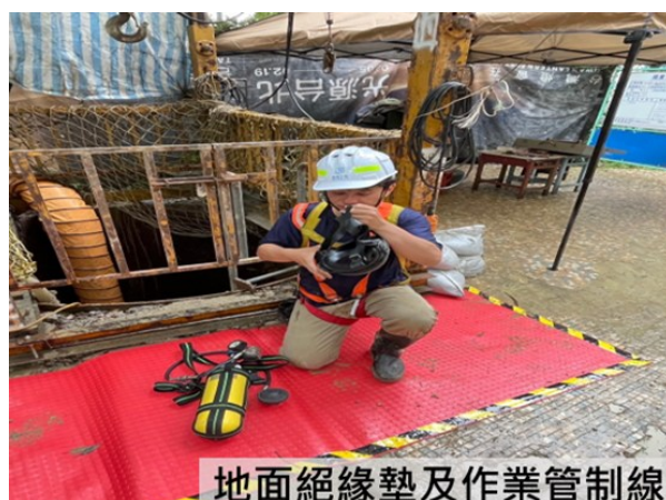
圖 5 設置電器絕緣墊及施工管制區示意圖
