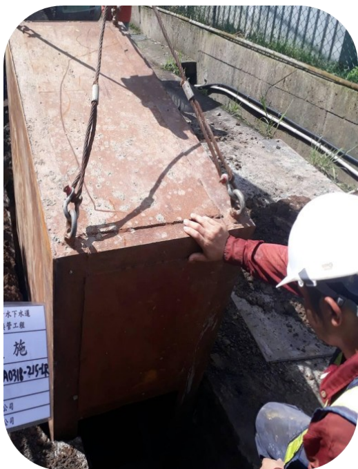
圖 2 優化擋土板門型架施工輔以管線開挖結構計算
