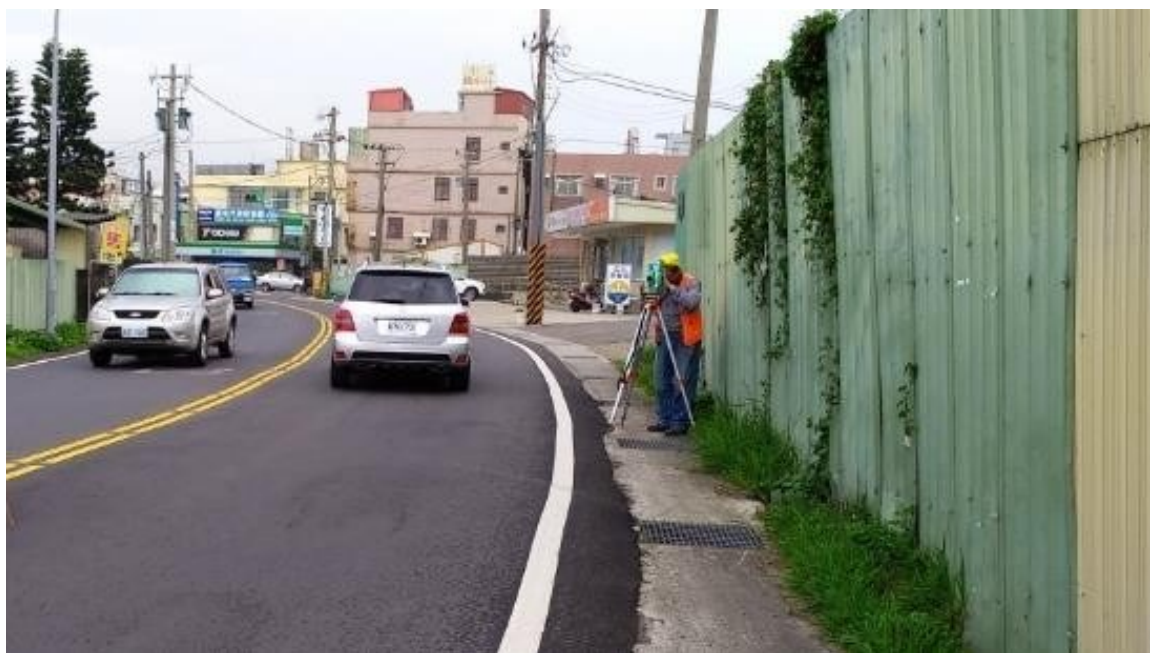
圖 11 曲線推進地面線形放樣
