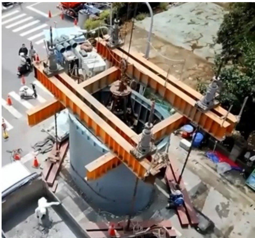
圖 6 異形工作井施工照片
