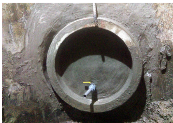
圖 5 現場管頭封牆設置洩壓閥及掛勾照片示意圖
