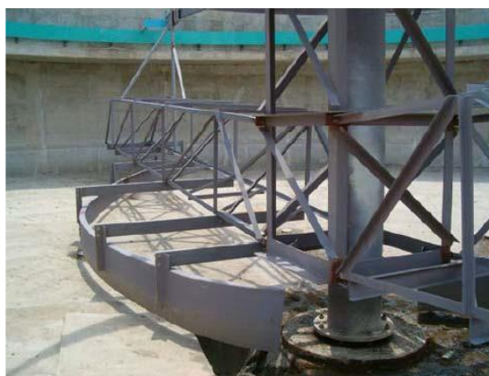
圖 6.38 螺線型刮板
