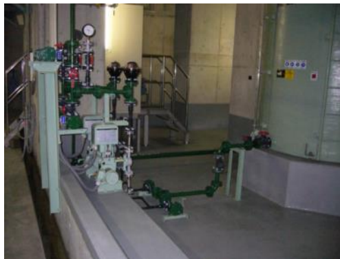
圖 9.4 次氯酸鈉加藥設施實景及示意圖
