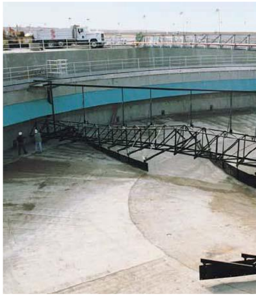
圖 6.41 百葉式彎刮板
