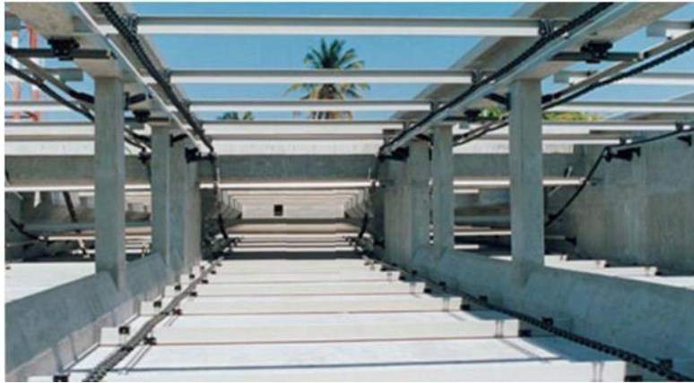
圖 6.34 長方形沉澱池池間採開孔隔牆
