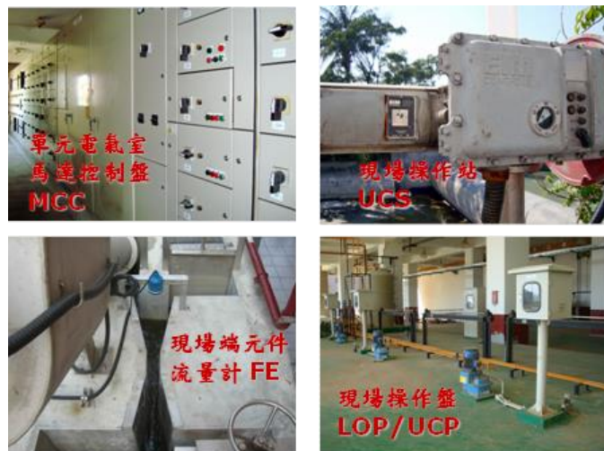
圖12.16 儀控系統組合配置實景圖之二
