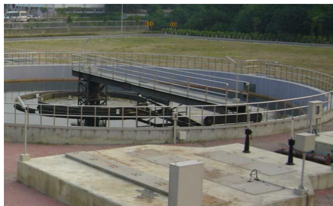
圖 6.45 周邊驅動式驅動機照片(斗六市水資源回收中心例)
