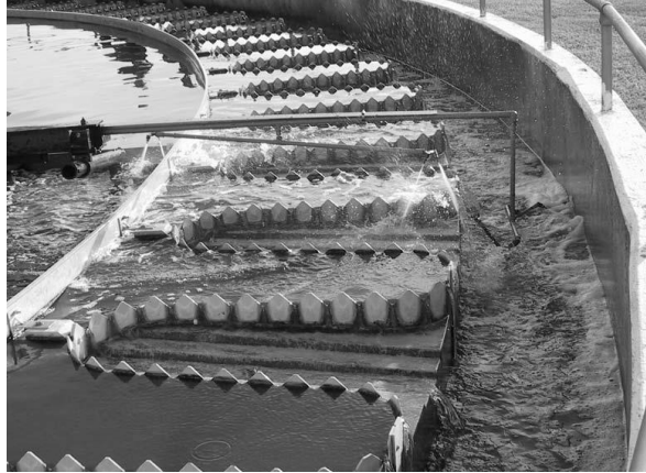
圖 6.26 噴水系統去除圓形池蛇狀溢流堰上的藻類
