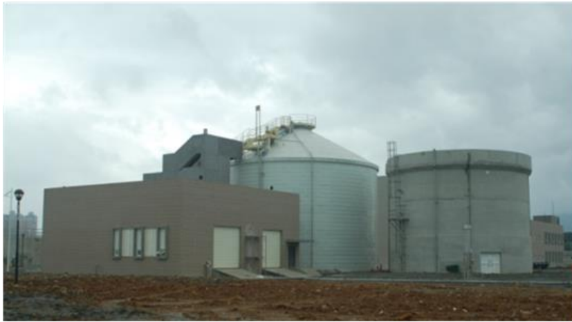
圖 10.21 厭氧消化槽(淡水水資源回收中心例)
