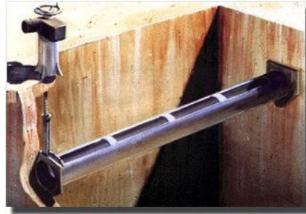
圖 6.21 長方形池刮渣管安裝示意圖
