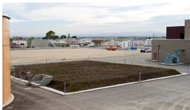
圖 11.9 除臭用生物濾床照片
