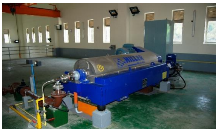
圖 10.43 離心脫水機系統例
