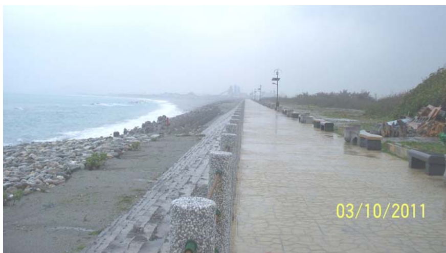
照片2.2.1 護岸例照
