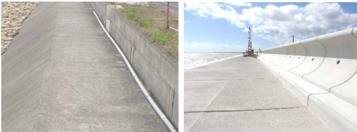
照片2.7.1 直立式胸牆(左)、反波式胸牆(右)
