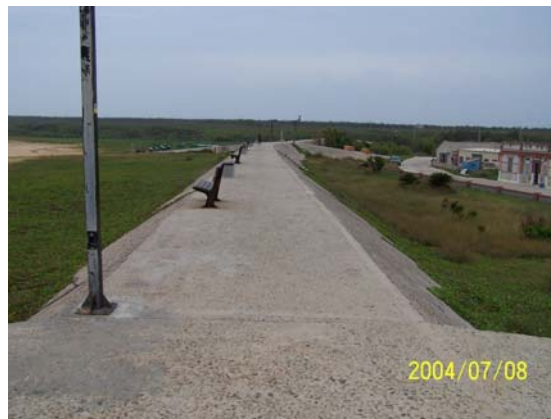
照片2.1.1 設於高灘禦潮之堤防
