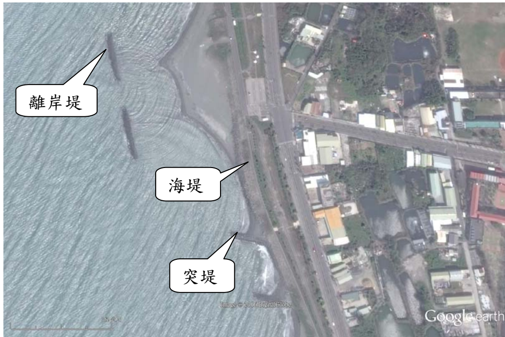
照片2.1 海岸防護設施主要設置型式示意照片(高雄茄萣海堤)
