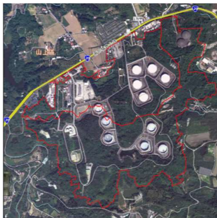
台南山上中油豐德供油中心(山保區)(公用設備)
