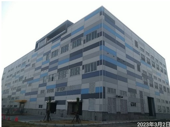
圖 4 安平再生水廠外觀現況
