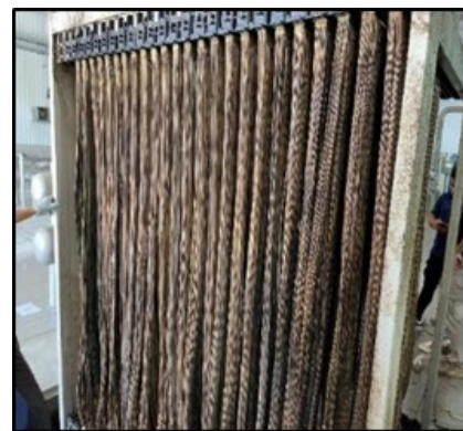
圖 6 原廠 MBR 膜組吊升功能檢查
