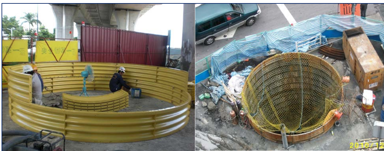
圖 4.3-3 鋼襯板施工示意圖
