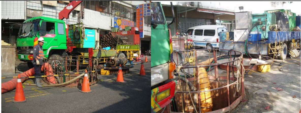
圖 4.3-7 不落地設備推進施工照片
