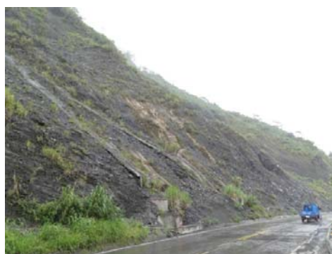
南山聚落崩-01：道路通行良好，但崩塌地仍呈現裸露狀態
