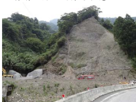
南山聚落崩-04：已進行坑溝整治及崩塌地治理工程
