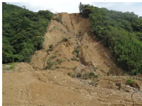
南山聚落崩-03：農路已恢復通行但崩塌地仍呈現裸露狀態
