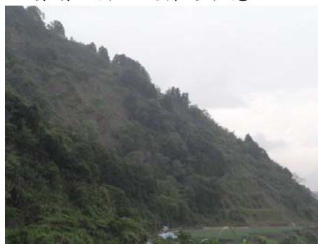
南山聚落崩-02：道路通行良好，但崩塌地仍呈現裸露狀態
