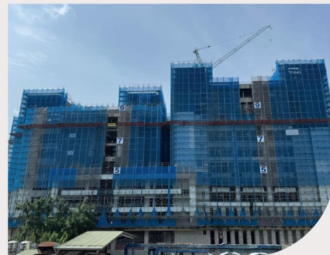
防塵網施工架外觀照片
