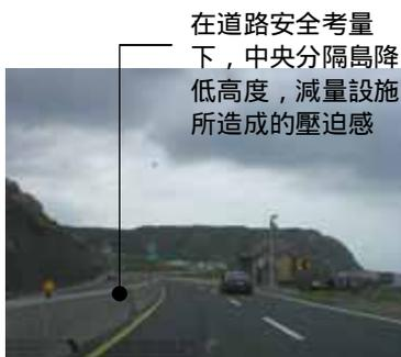
在道路安全考量下，中央分隔島降低高度，減量設施所造成的壓迫感
