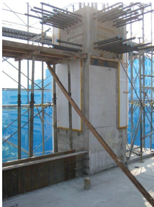
(2)實際梁柱接頭施工圖
