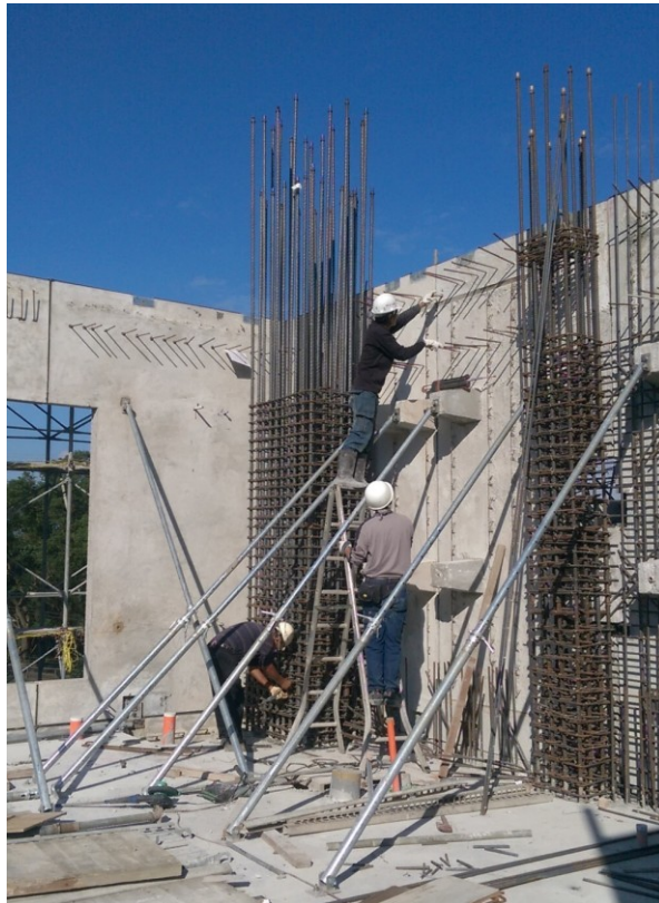
圖 R7.4 牆板預鑄構材組立用斜支撐之例
