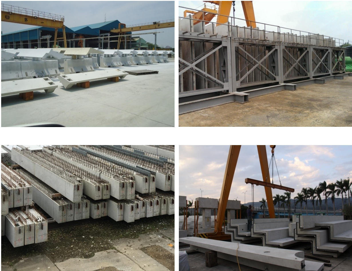
圖 R6.1 各類預鑄構材儲存方式示意圖
