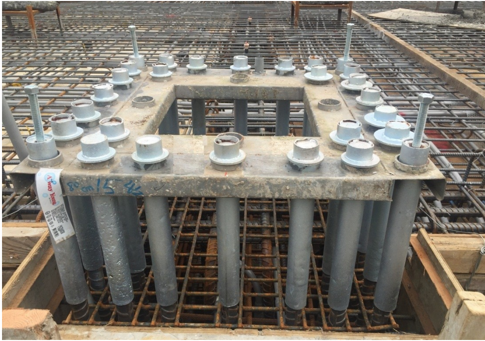
圖 R9.4 接合用鋼筋之定位板照片
