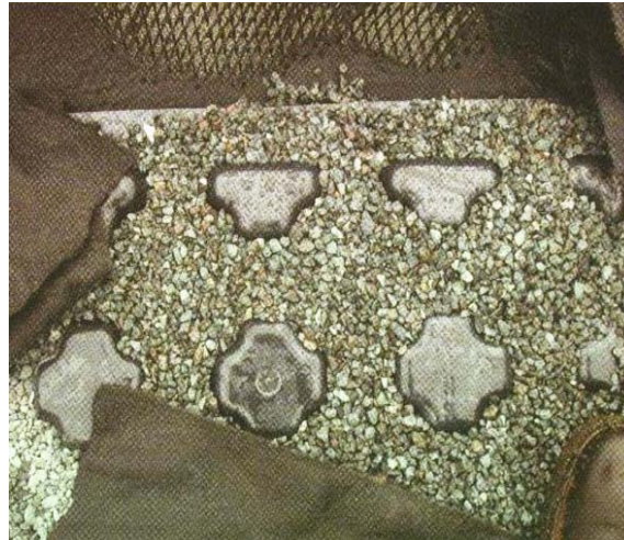
▲圖 3-6- 15·通氣層與排水層使用之資材 資料來源: Werthmann, C., 2007, p.115
