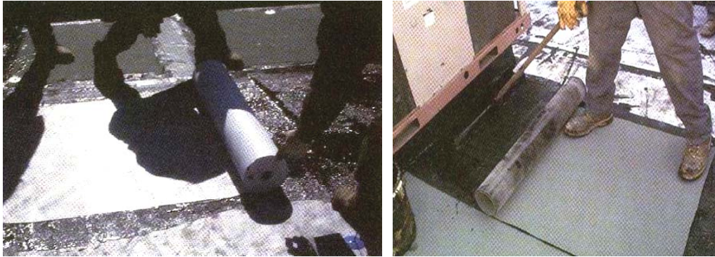
▲圖 3-6- 13，鋪設防水層與阻根層的施工過程照
