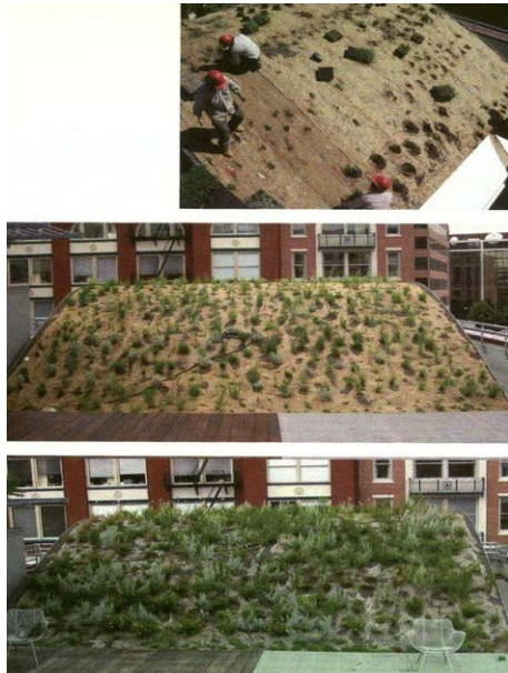
▲圖 3-6- 16，ASLA 生態屋頂植栽層完工圖 （由上而下為生長情形） 資料來源：Werthmann, C., 2007, p.104
