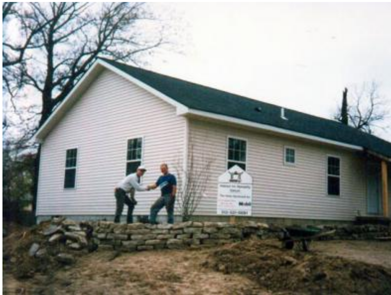
▲圖 3-3- 1，水泥鋪面回收再利用成為景觀矮牆
