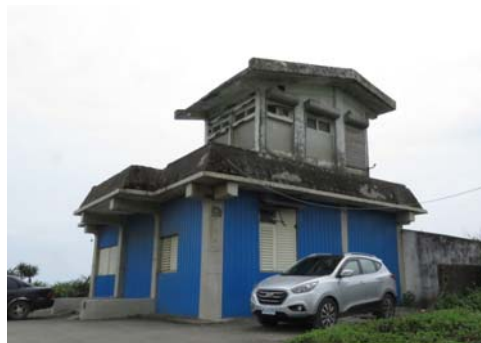
閒置海巡建築
