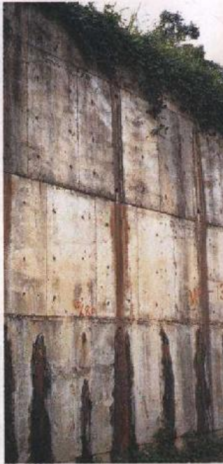
牆面排水管出水量較多的排水設計
