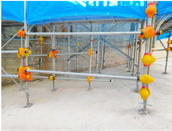
車道處施工架基座座鈑 採可調整角度與地面密接
