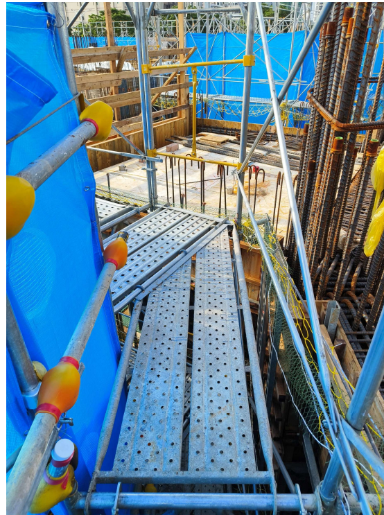
施工架畸零踏板定製
