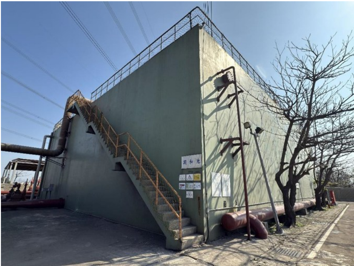
圖4 臺中港特定區水資中心調和池（有效容積約 4,000 m 3 ）
