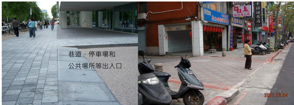
圖3-4 連續設置且平順銜接的人行道實景
