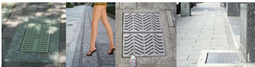
圖3-10 排水溝進水隔柵或隔板示意圖
