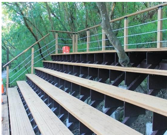
↑ 105 年颱風災後重置成果， 半屏湖階梯教室改善後 (壽山籌備處提供)
