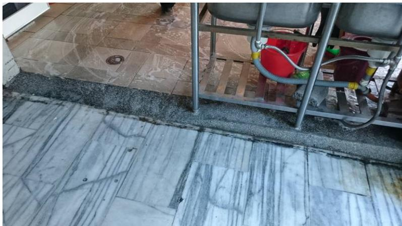
(2)坡道處理：部份路段高低差處理不符合無障礙設計規範坡道之坡度比。
