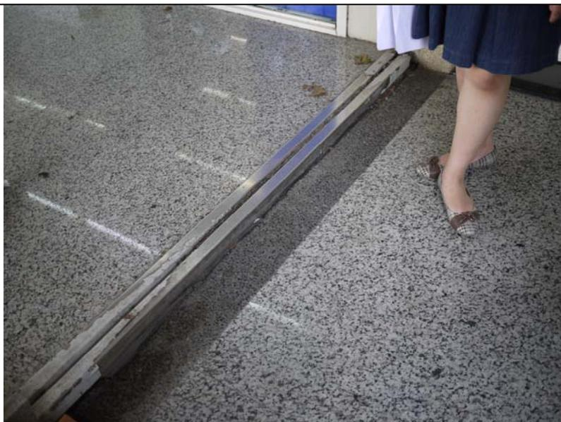
(2)水溝蓋方向：水溝格柵不符合無障規範之室外通路之相關規定。
