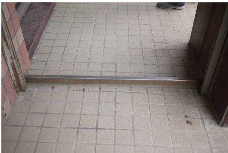
(2)坡道處理：騎樓兩端坡道處理不符合無障礙設計規範坡道之坡度比。
