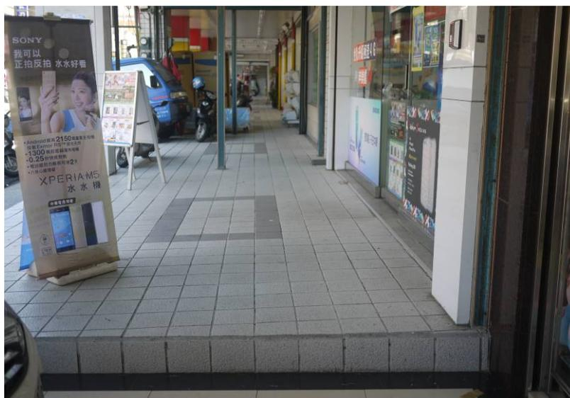
(2)坡道處理：騎樓兩端坡道處理不符合無障礙設計規範坡道之坡度比。
